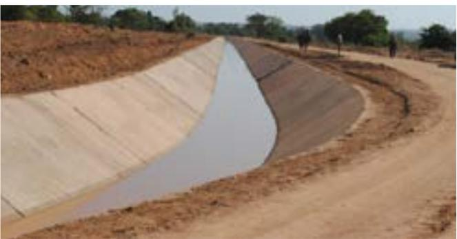
25 Km de canal en béton armé
