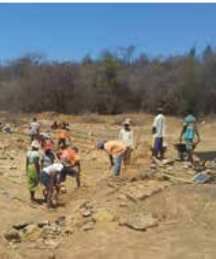
Mise en place des mesures anti-érosives, commune Anahidrano, Région Sofia, Septembre 2019
