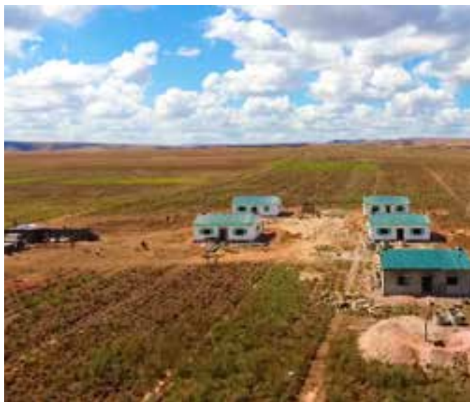
ZEA en construction à Ambatomainty Sud
