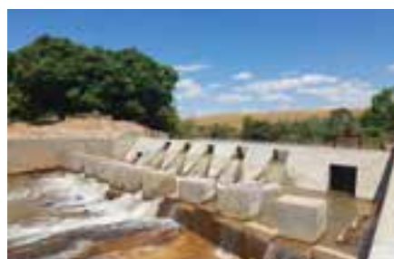
Réhabilitation des périmètres à Mahabe
