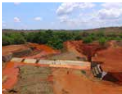
Travaux d'aménagement du périmètre irrigué de Marifilaly
